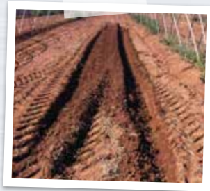
Auftürmen der Dämme
